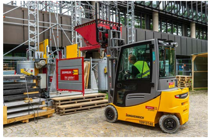
Bild 4 Neben den Aufzügen war auch ein Elektro-Stapler „EFG 320“ von Zeppelin Rental im Einsatz. Dieser kann bis zu zwei Tonnen transportieren.
