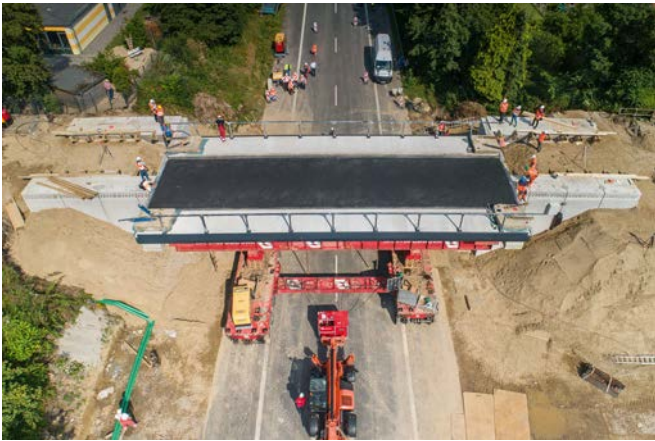
Bild 5 B68 Schulstraße, Georgsmarienhütte – Einschub fertiggestelltes Brückenbauwerk
