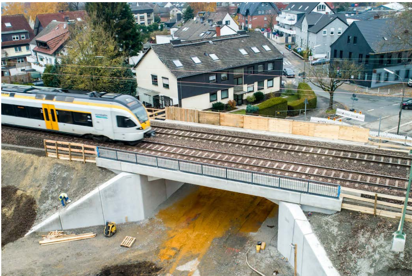
Vellinghauser Straße, Foto: Echterhoff
