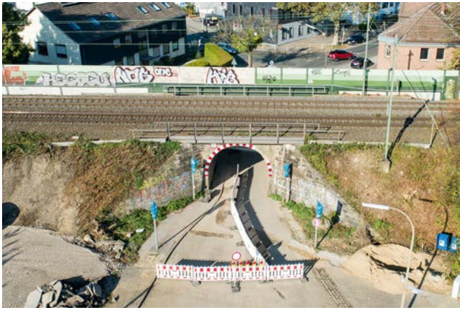
Bild 9 Vellinghauser Straße, Dortmund – alte Bestandsbrücke aus Naturstein, Baujahr 1880
