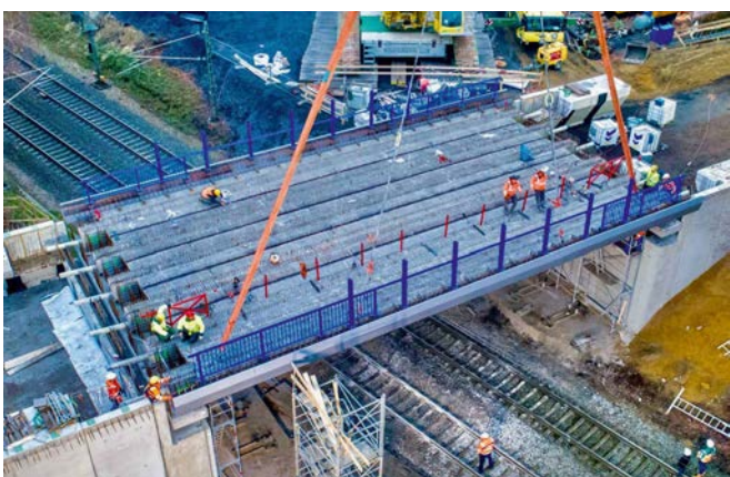
Bild 2 B474 OU Dülmen–Auflegen der Spannbetonüberbau fertigteile mit aufgesetzter Hybridkappe sowie Geländer- und Berührungselementen; Gesamtbauzeit: 40 Kalendertage
