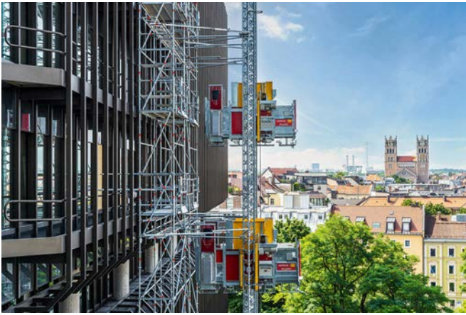
Bild 2 Vorkonstruktion: Aufgrund der Balkone, die als Fluchtwege dienen, mussten die Aufzüge an einem Gerüst montiert werden.
