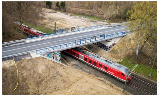
Bild 8 B474 OU Dülmen – Fertiges Brückenbauwerk nach 40 Kalendertagen
