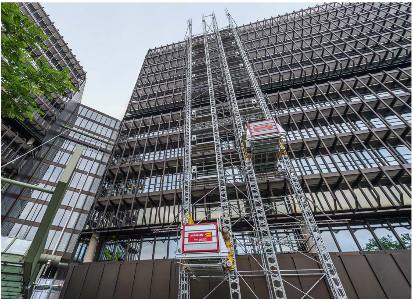
Bild 1 Insgesamt 40 Meter misst das Mastsystem am Europäischen Patentamt. Neun Etagen können so erreicht werden.
